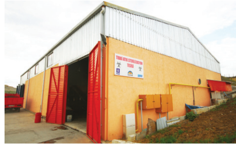
Tıbbi Atık Sterilizasyon Tesisi
